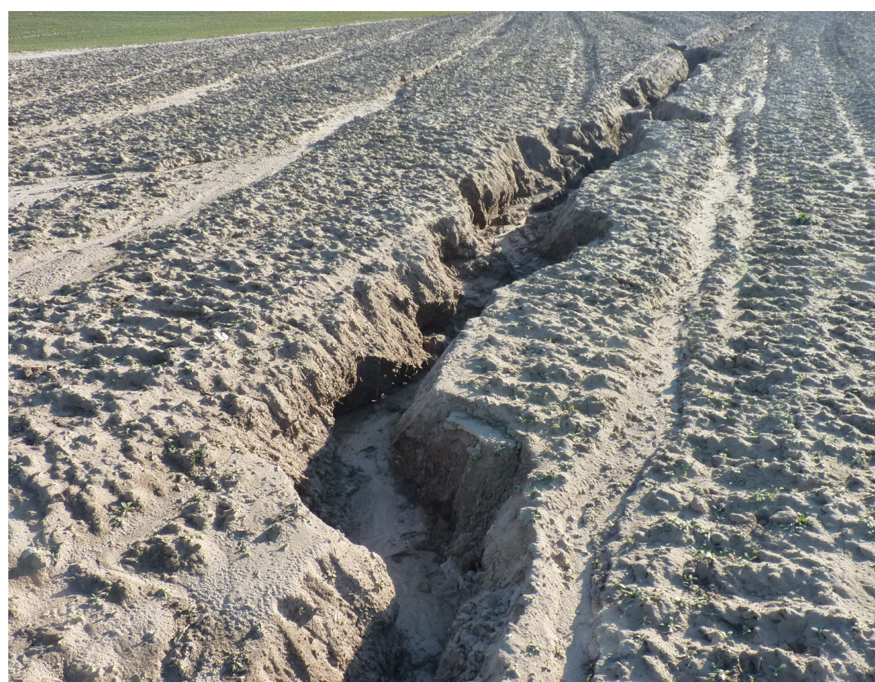
Unzureichender Bodenschutz während der Baumaßnahmen
