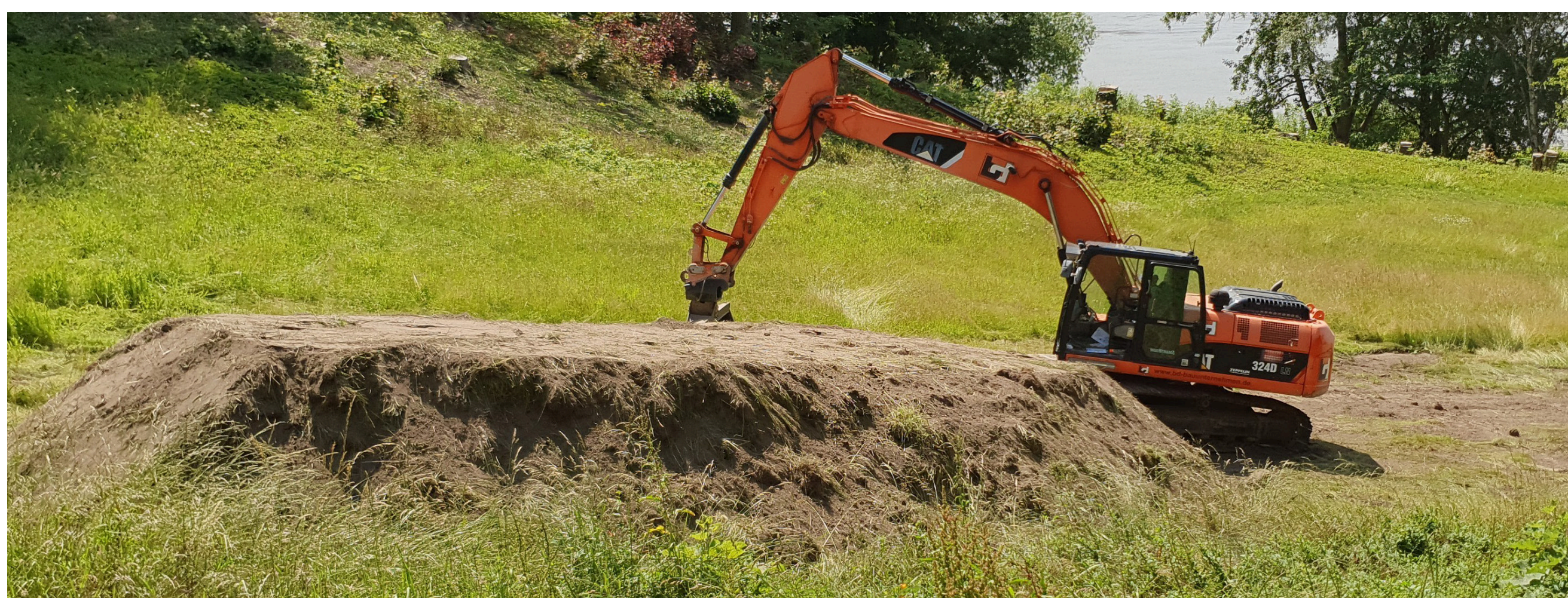
Vorsorgender Oberbodenabtrag und -auftrag
